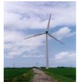
▲庄内町の風力発電所
